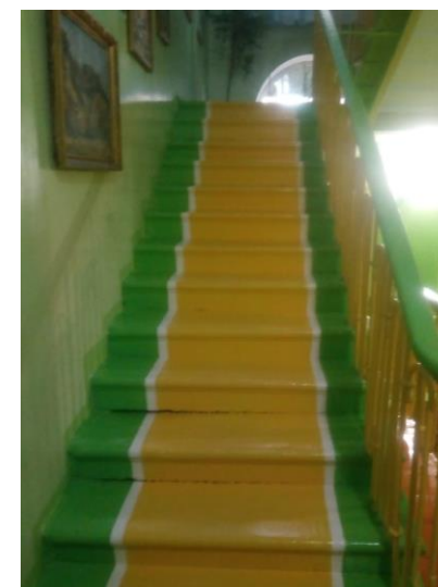
Фото 9 Лестница внутри здания
