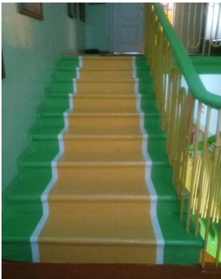
Фото 10 Лестница внутри здания
