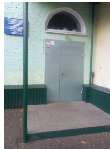
Фото 3 Входная площадка (перед дверью)
