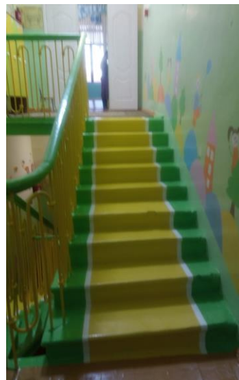
Фото 12 Лестница внутри здания
